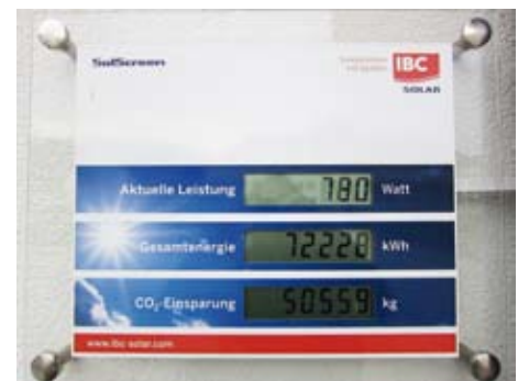
Anzeigetafel der Photovoltaikanlage: Stromerzeugung und CO 2 Einsparung
