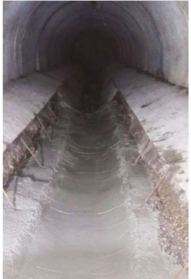
Sanierung des Edlesbaches
