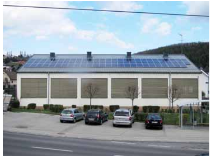
Erneuerbare Energie: Neue Photovoltaikanlage am Dach der Mehrzweckhalle
