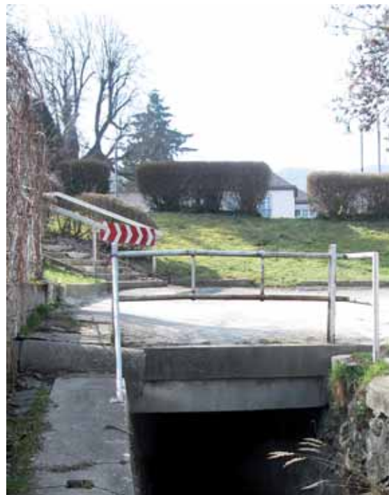
Edlesbach soll saniert werden
